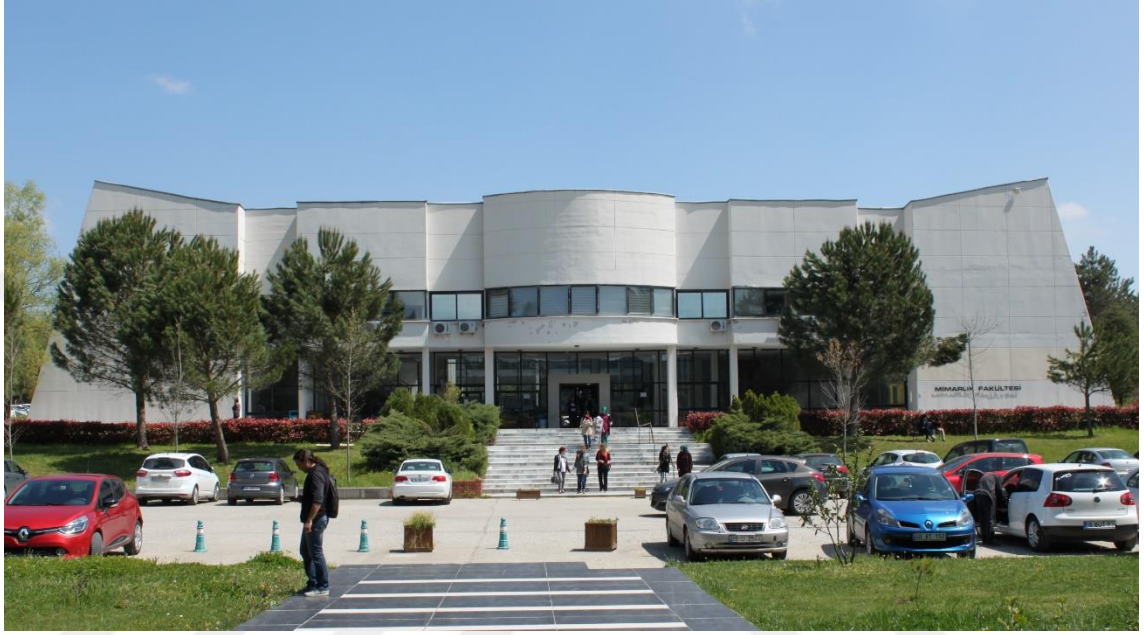
Şekil 4.12. Mimarlık Fakültesi Mimarlık Bölümü Binası Giriş Cephesi
