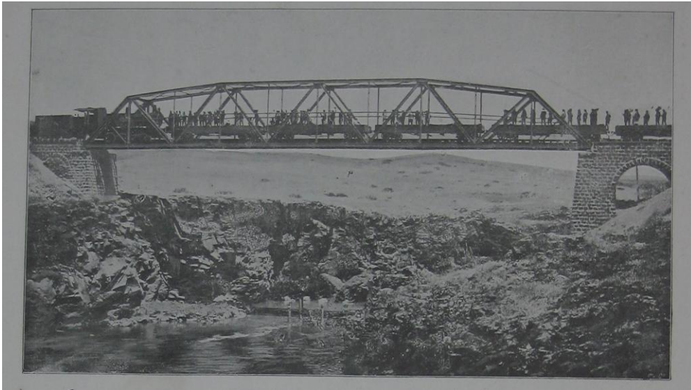
1907 Hayfa'yı Hicaz demiryolu hattına bağlayan tren hatının 79. Kilometresindeki elli metre uzunluğunda demir köprü (AESLN 235, s.57.)
