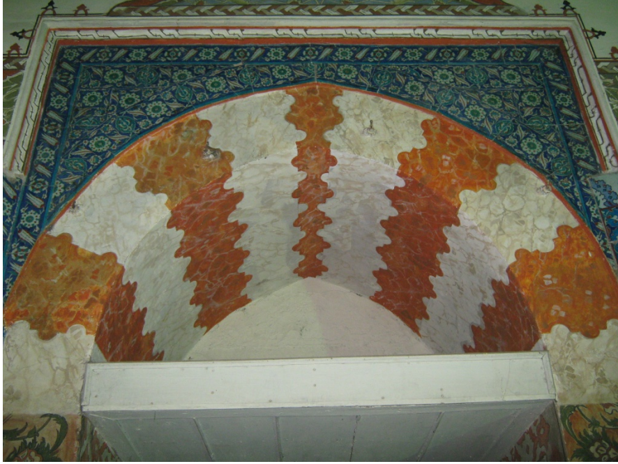
Resim 16 – Kapının Sivri Kemerini
