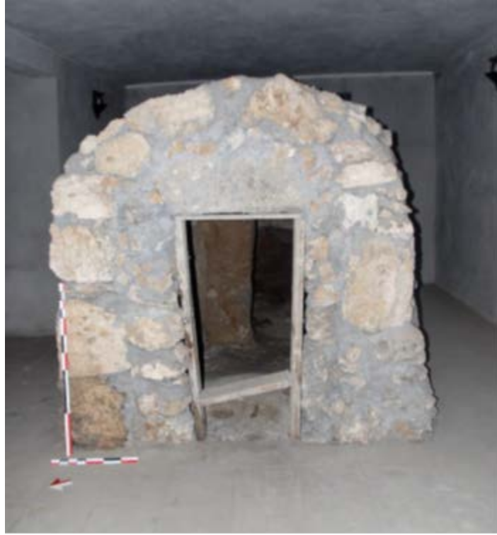
Resim 4: Çimento Harcı Kullanılarak Onarılan Bölümlerden Örnek
