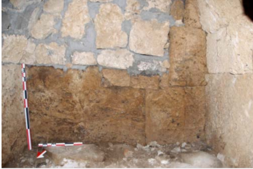
Resim 5: Duvar Örgü Tekniğini Gösterir Fotoğraf
