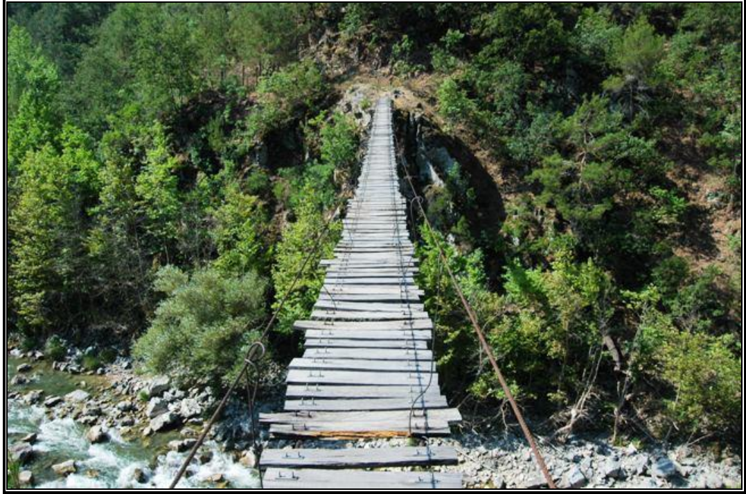
Şekil 6.50. Tarihi Burunca Köprüsü
