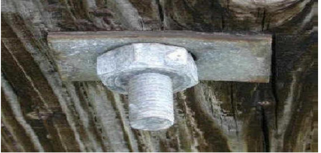
Şekil 3: Farklı metallerin oluşturduğu korozyon
