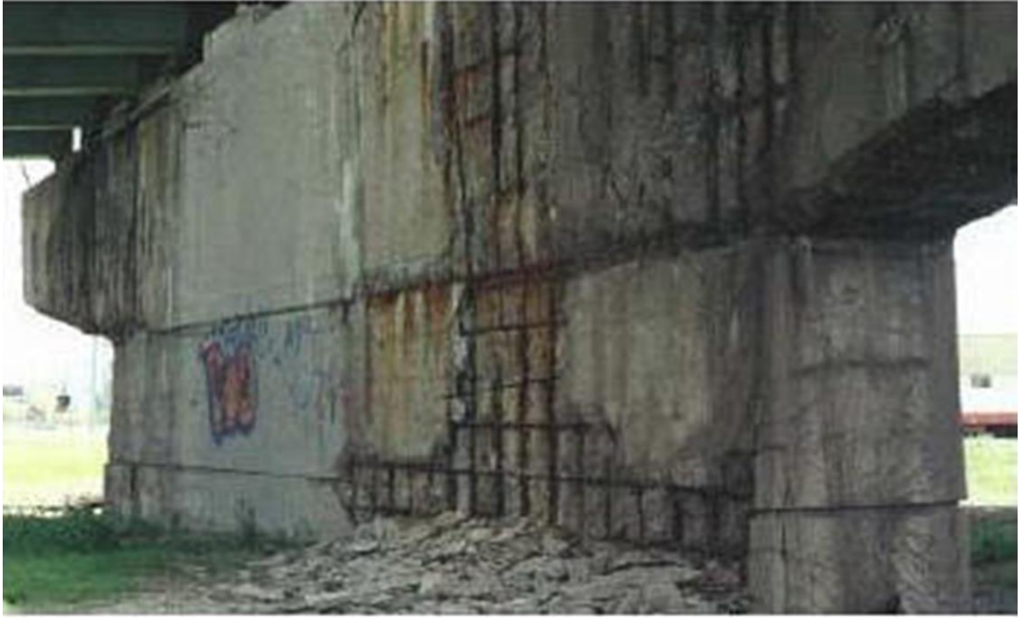
Şekil 2: Metal yüzeyinde korozyon (Hasarlı viyadük ayağı)
