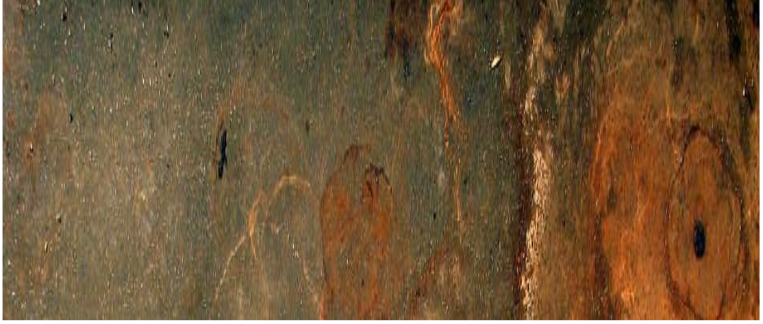
Şekil 1: Metal yüzeyinde korozyon
