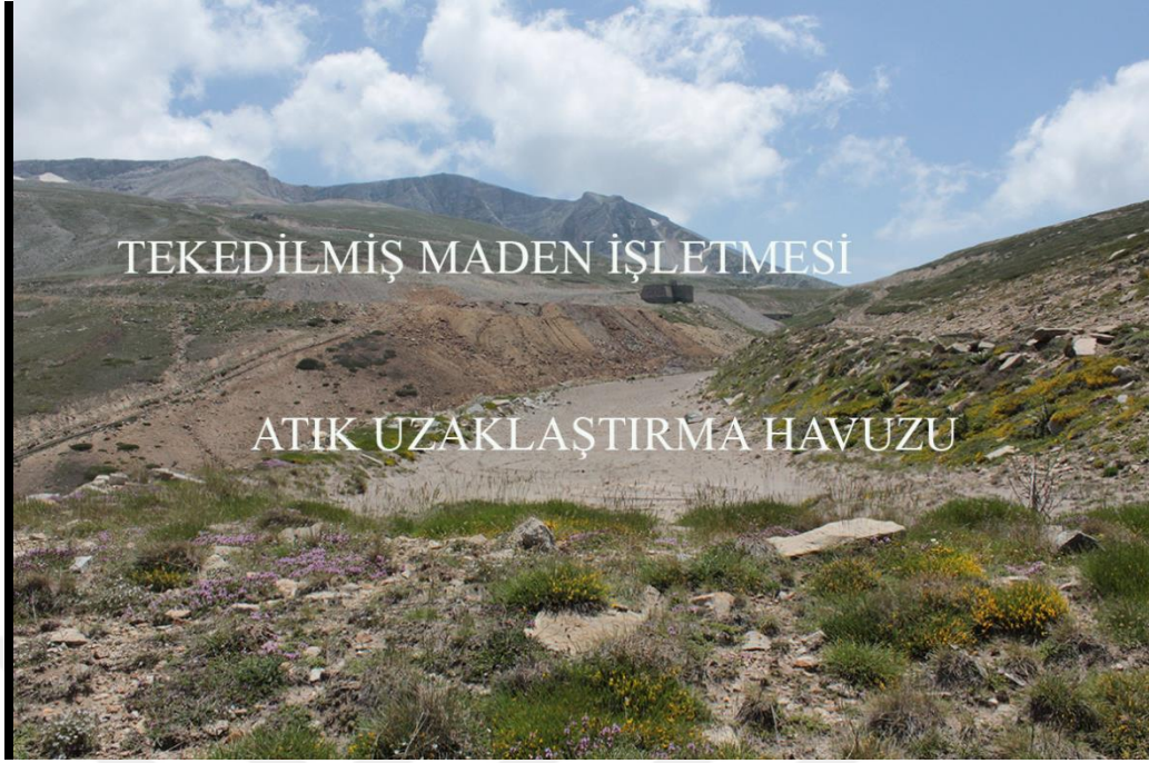
Şekil 3.2.2 Terkedilmiş Etibank Wolfram Maden işletmesi ve atık uzaklaştırma havuzu (Foto:G.Gülyüz).
