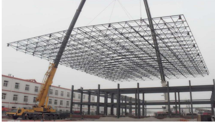
Şekil 2.5. Düzlemsel Çift Katlı Uzay Kafes Sistemler (Sıfır Gaussian Eğriliği)
