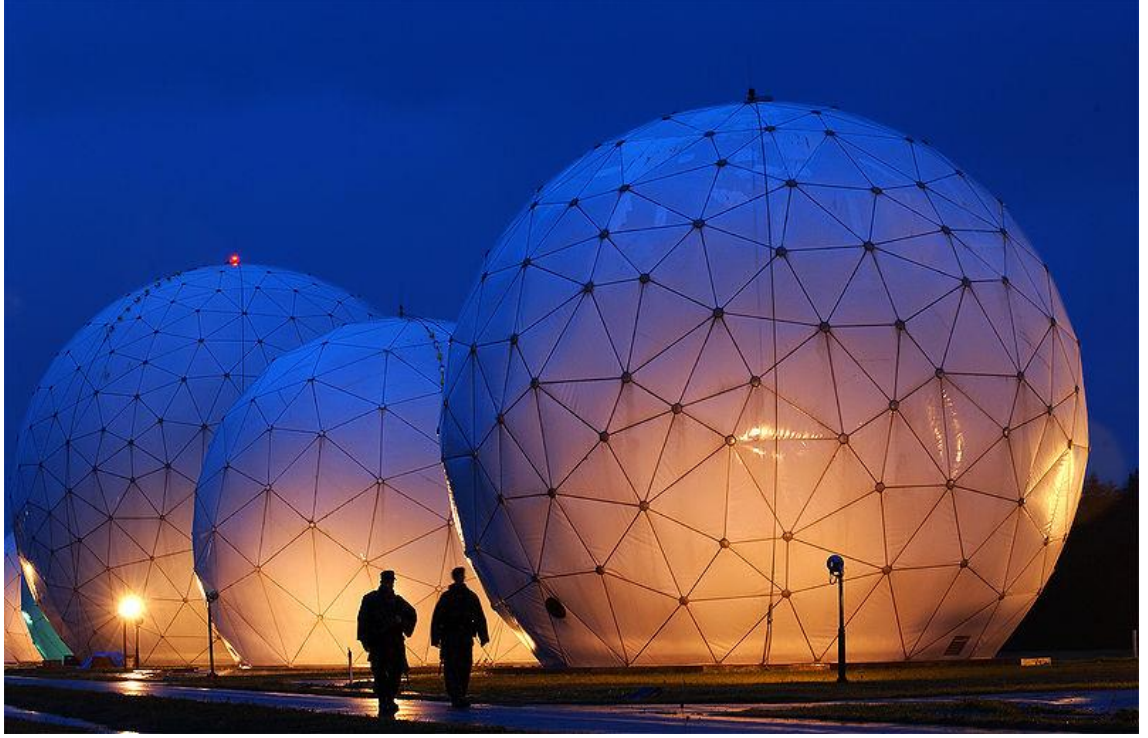
Askeri Radar İstasyonu (Anonim 2010)
