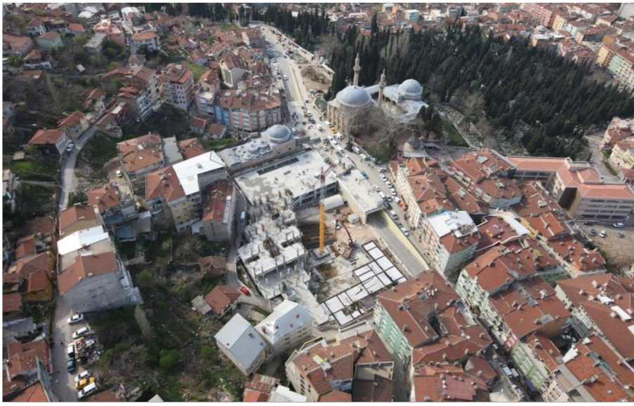
Şekil 3.41. Kentsel dönüşüm projesi inşa çalışmaları
