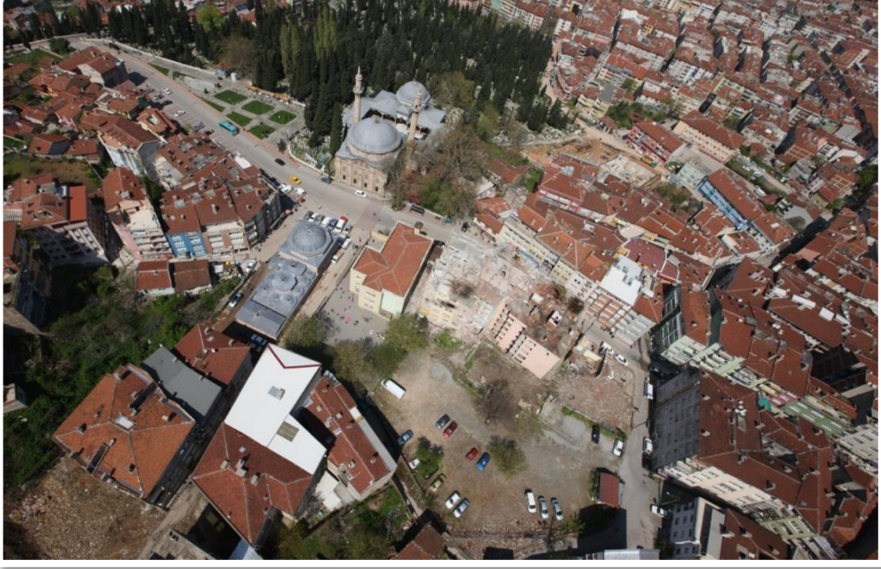
Şekil 3.40. Kentsel dönüşüm projesi yıkım çalışmaları
